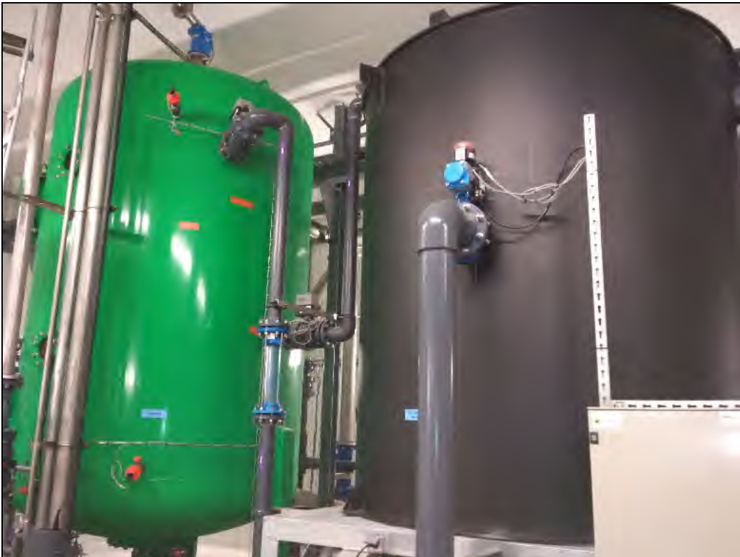
Photo 8 : Élimination des nitrates grâce aux résines anioniques
