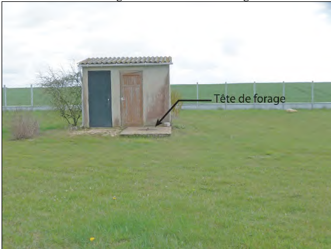
Photo 5 : Aménagement de la tête de forage, vue vers le Sud-Est
