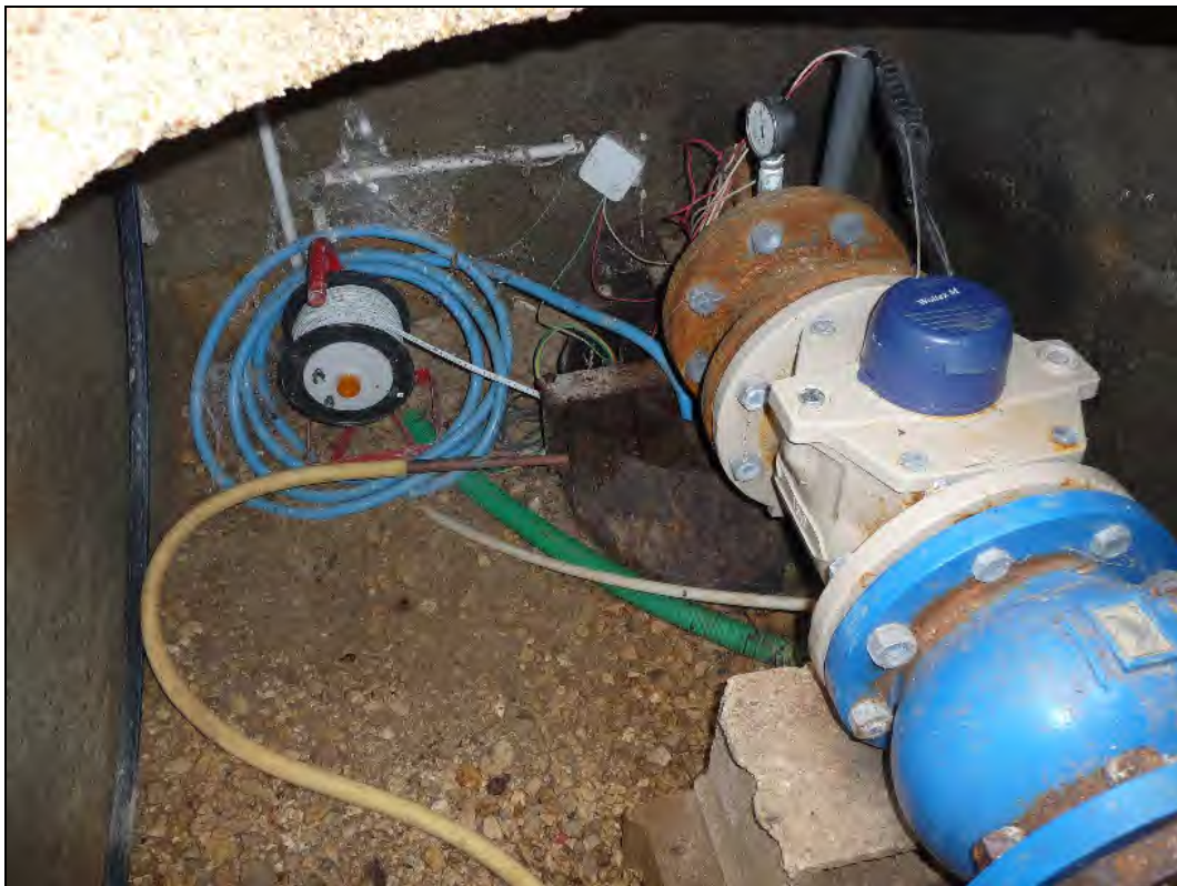
Photo 6 : Tête de forage
